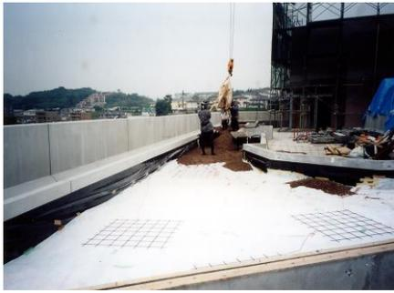
⑥土壌搬入：軽量土壌を使用し建物への加重軽減をいたします。クレーン等を用い搬入します。
