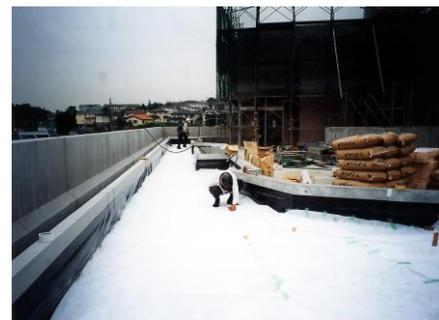
⑤透水フィルターの敷き込み: この上のにる土を降水雨などにより下の層へ流出させない役割があります。
