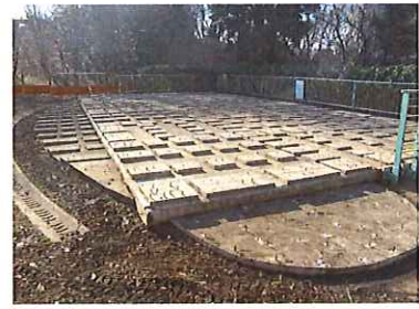
基礎部分確認
