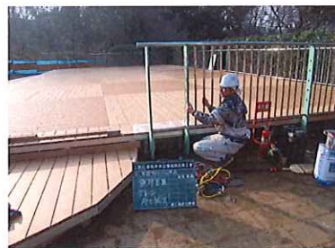
手摺り修繕工
